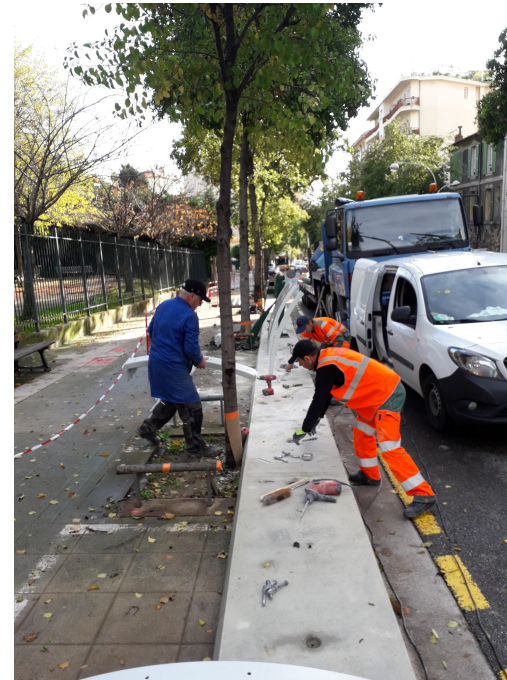
Alignement des semelles et pose des poteaux
