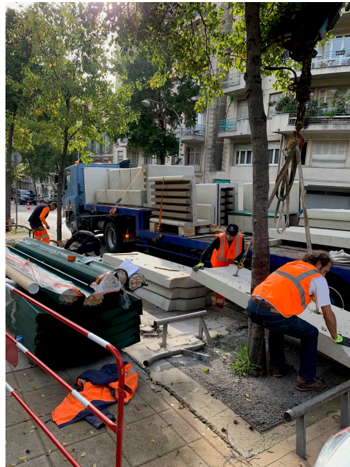
Pose et réglage de la semelle
