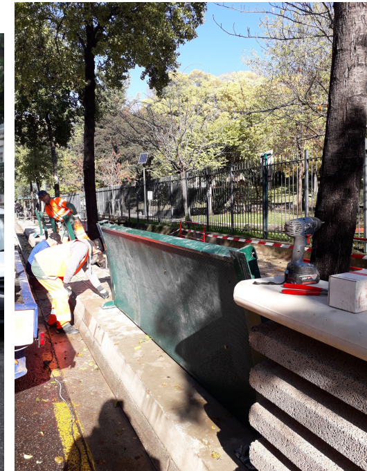
Montage des parements
