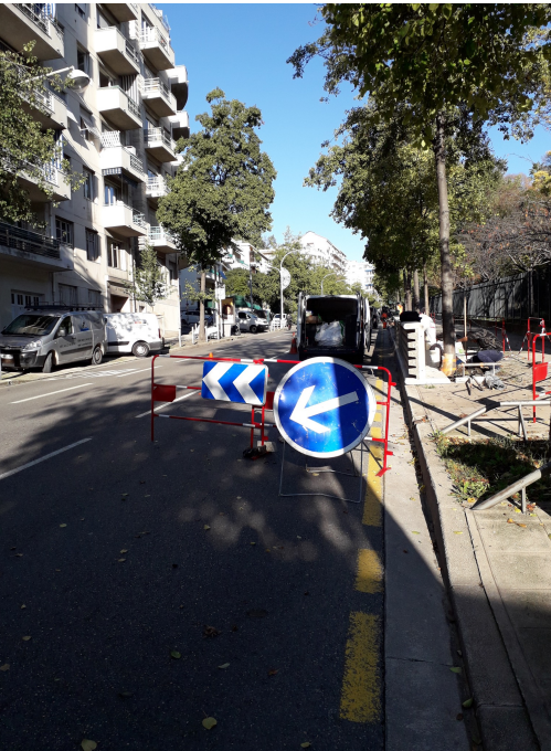
Emprise du chantier réduite à une voie
