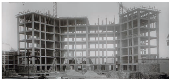
HBM Structure poteaux-poutres en béton
