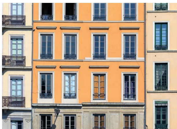
Construction en pierre
