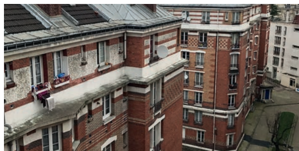
HBM Façades en briques
