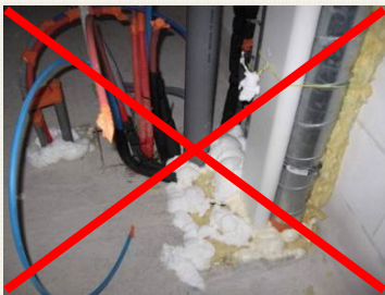
Figure 3.2.1 : Traitement du passage de plancher
