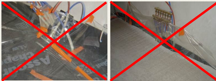
Figure 3.1.5 : Illustration de mauvais traitement des points singuliers
