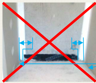
Figure 3.1.3 Exemple de discontinuité d'isolant : le sol flottant en couloir
