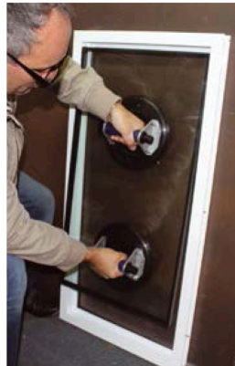
Technique n°1. Remplacement du vitrage (doc. ESPACE9)
