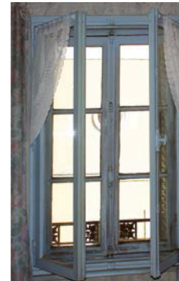
Technique n°3. Pose de doubles fenêtres (doc. ESPACE9)
