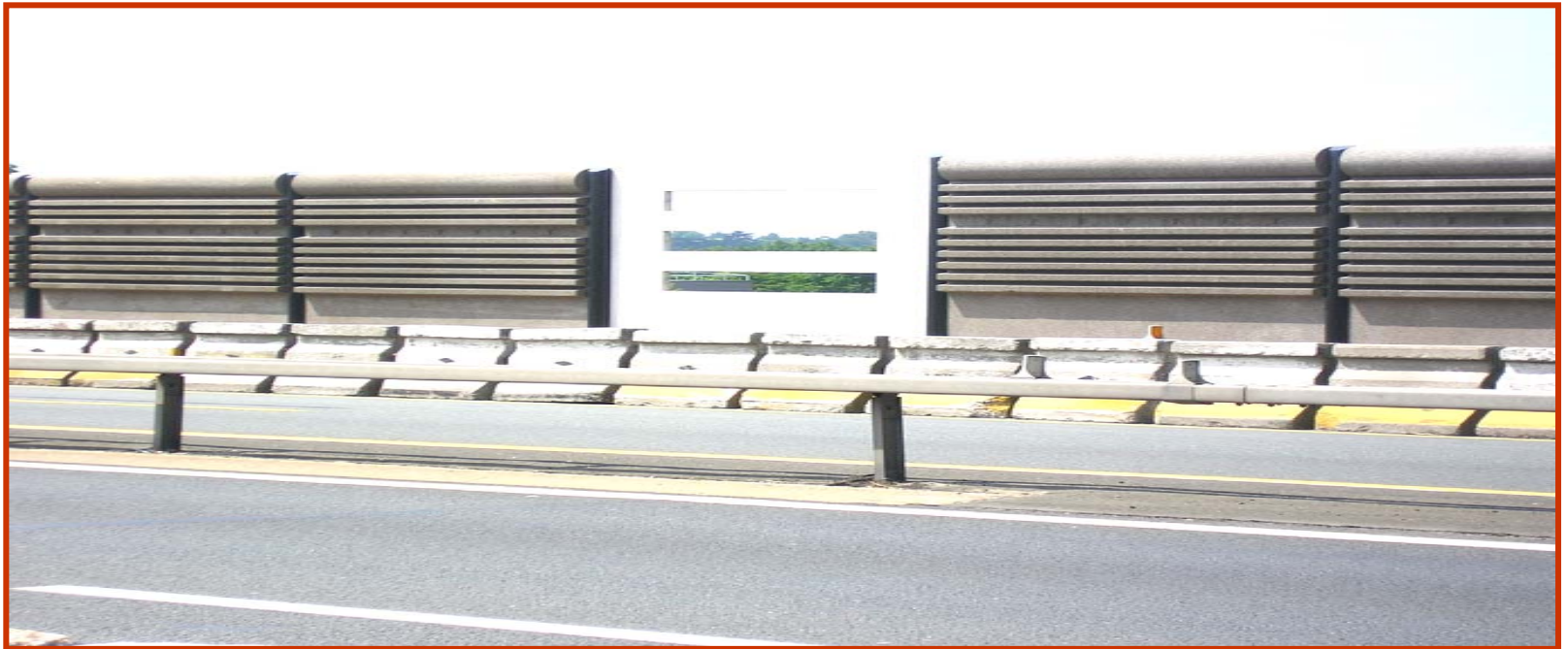
Couronnement et longrine intégrés sur élément toute hauteur
