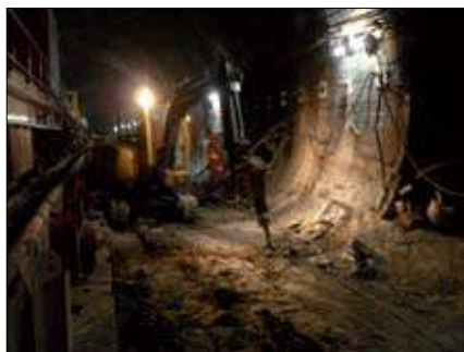
Fig. 1 : Exemple de source vibratoire : pelleuse équipée d'un BRH (vitesse particulière)
