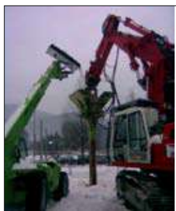
Fig. 4 : Exemple de source vibratoire : construction de colonne ballastée (vitesse particulière)
