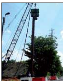
Fig. 2 : Exemple de source vibratoire : battage de palplanches (vitesse particulière)
