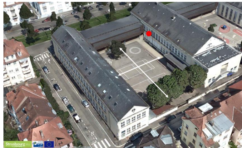
Mesures de DL sur deux axes (longitudinal et transversal)
