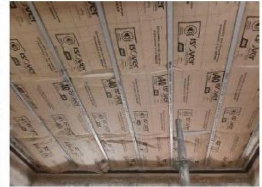
Pose de l'ossature et l'isolant (Essais 23 à 39)
