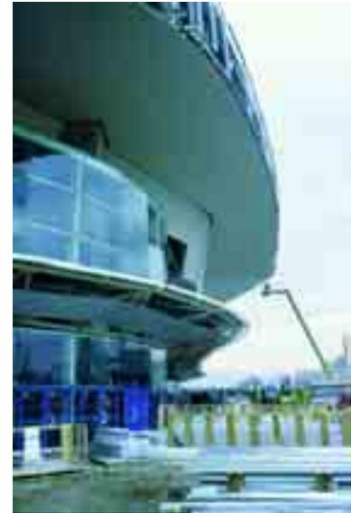
La charpente de 1000 tonnes, de 80 m de portée et de 45 m de hauteur contient les éléments scéniques faisant partie du spectacle, gril, plate-formes de poursuite, passerelles techniques nécessaires pour la mise en place du son et des éclairages.
