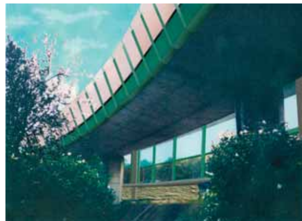
Écrans situés sur et sous le petit viaduc de Vélizy
