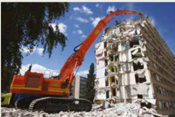
Démolition : une pince hydraulique pour limiter les nuisances sonores
