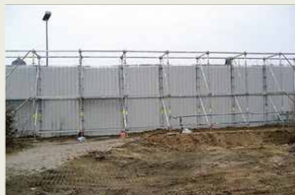
Paroi antibruit mobile de chantier
