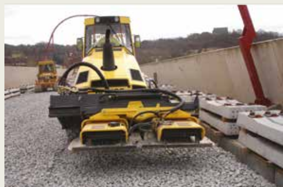
Planning travaux : d'abord les panneaux anti-bruit et après le chantier
