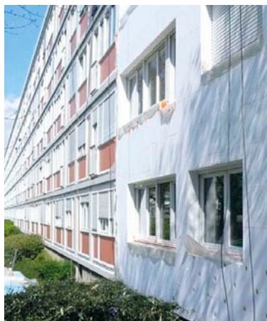
Pose de l'isolation extérieure Intérieur avec parement
