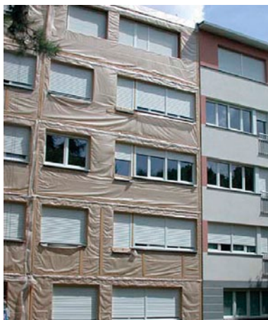
Pose des panneaux bois
