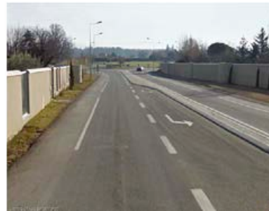
Mur de clôture - Traitement de type « urbain »
