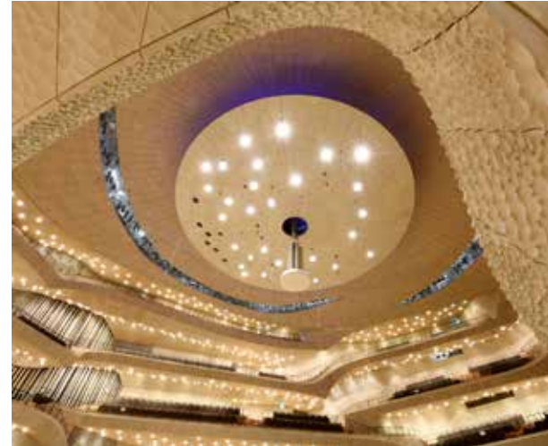
© Michael Zapf Un réflecteur acoustique situé à 15 mètres au-dessus de la scène
