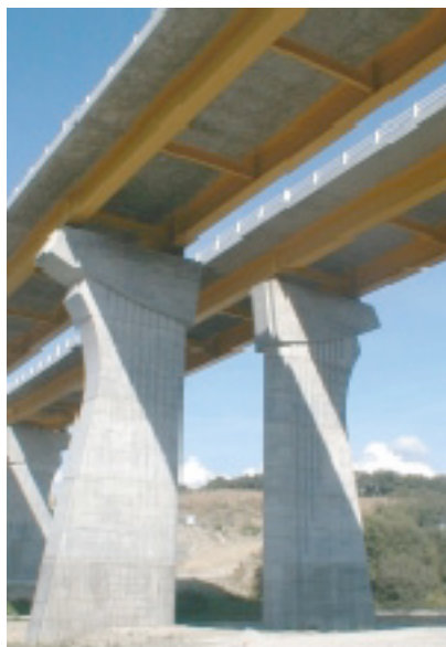
Le viaduc sur l'Hyères, ouvrage majeur de la déviation de la RN164 au niveau de Carhaix
