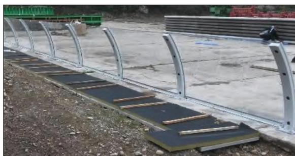
Fig. 6 : Prises de vue des trois prototypes installés sur le site d'Heyrieux. Haut : prototype Mice (écran métallique et laine minérale) – milieu : écran PBM en béton et béton de bois – bas : écran Idetec en PMMA et absorbant au sol. Views of the three prototypes set up in the Heyrieux site (France). Top: Mice prototype (metal screen with mineral wool) - middle: PBM prototype (concrete and wood concrete) – bottom: Idetec prototype (PMMA and absorbing material on ground).
